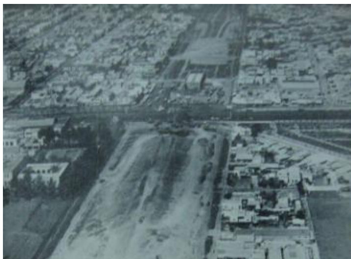
Construcción a la altura de la Av. Rivadavia, año 1938
