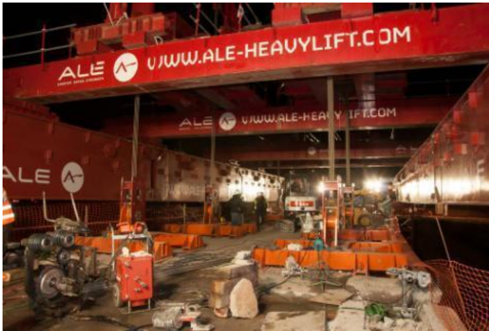
* Anclajes de vinculación tablero – Estructura de deslizamiento
