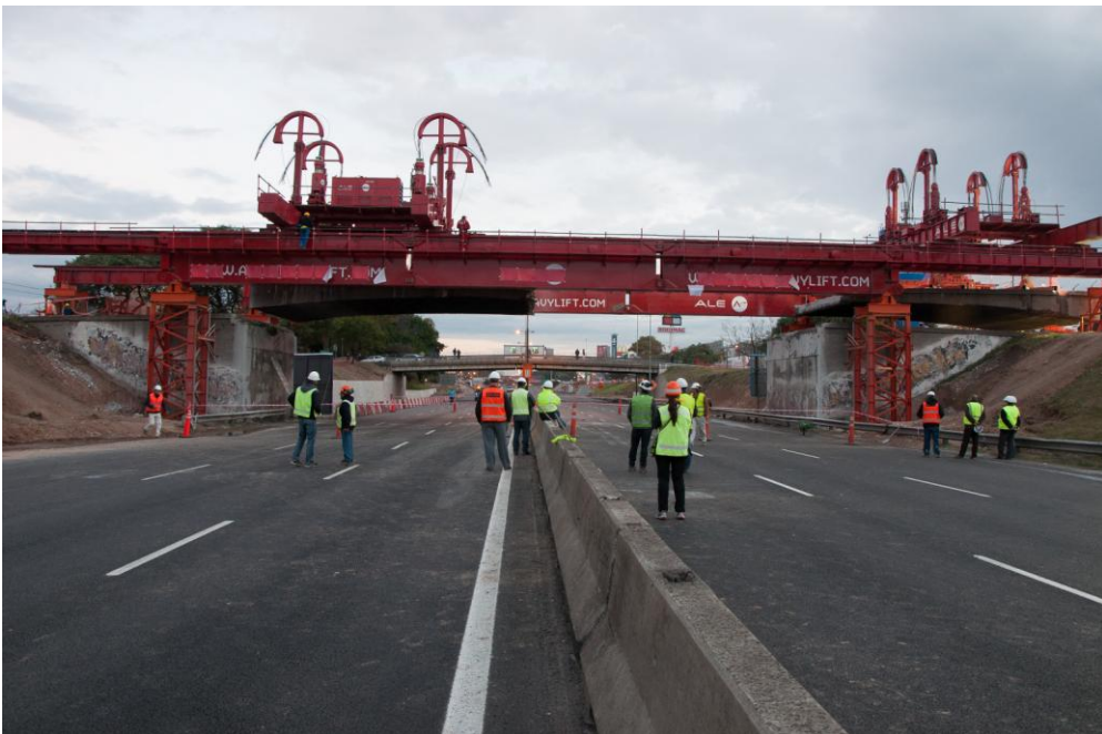
* Secuencia de Izaje y Deslizamiento del Tablero Seccionado
