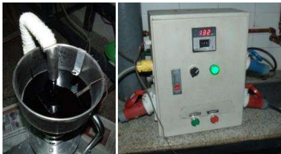
FOTO 2. EMBUDO CON ASFALTO VIRGEN – TABLERO CONTROL TEMPERATURA
