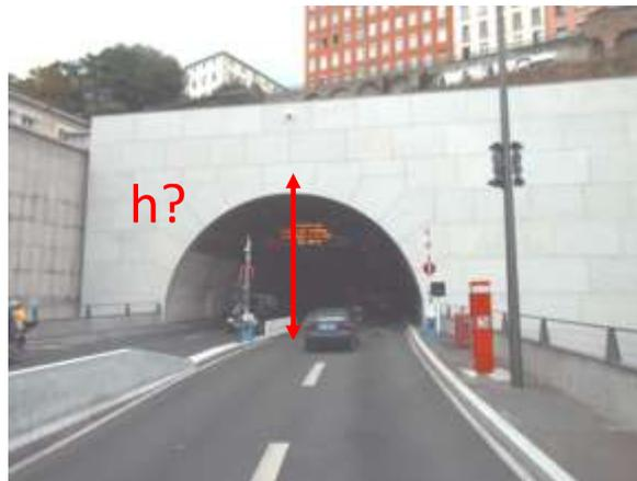
Figura 10: Altura libre bajo estructura
