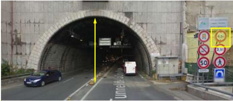
Figura 21: Entrada a un túnel. Altura libre permitida indicada en la señalización
