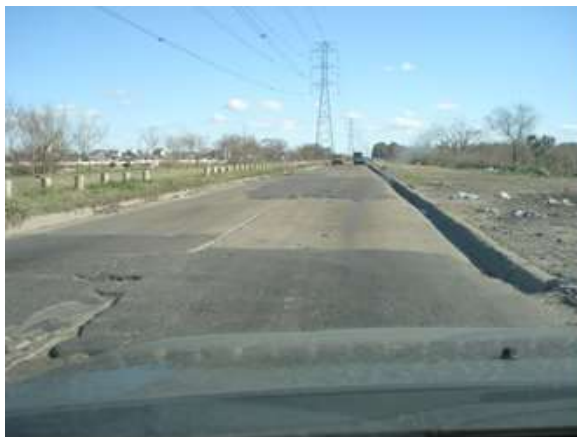
Fotografías de calzada existente acceso Barrio La Salada - La Matanza.
