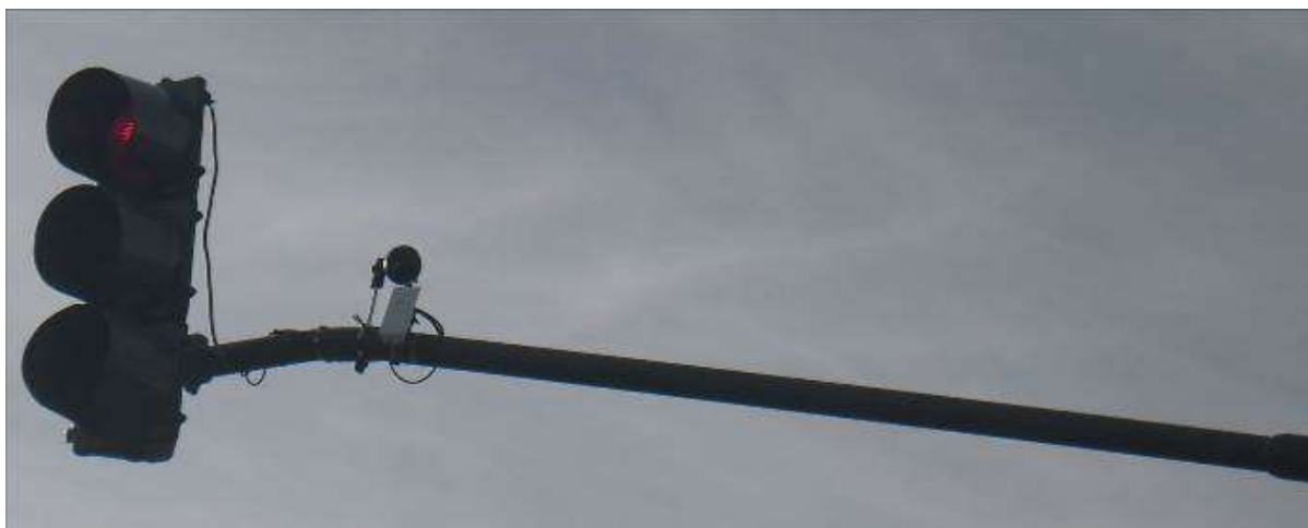
FIGURA N° 14. Equipamiento para el Sistema de Detección del Tránsito sobre columna semafórica.
