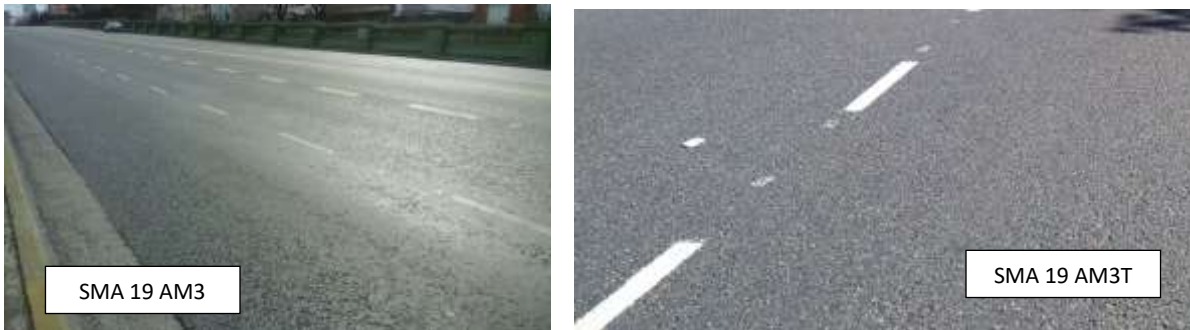
Figuras 1 y 2 Estado superficial tramos mezcla SMA 19 AM3 y SMA 19 AM3T.
