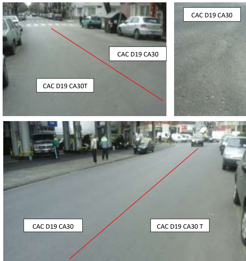
Figuras 3, 4 y 5 Estado superficial tramos mezcla CAC D19 CA30 y CAC D19 CA30T.
