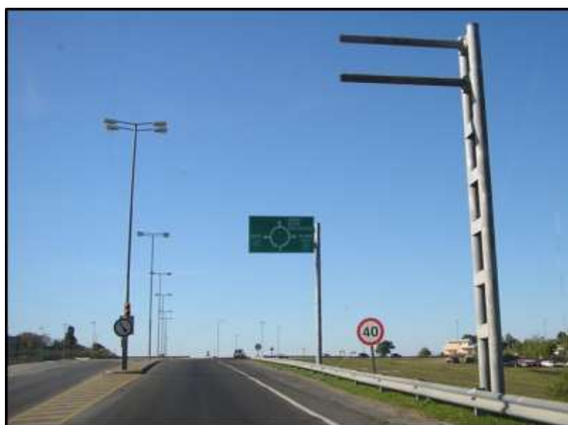
Fotografía N° 3: Llegada por RN 174 (Ramal Sur), en rampa (Intersección N° 1)
