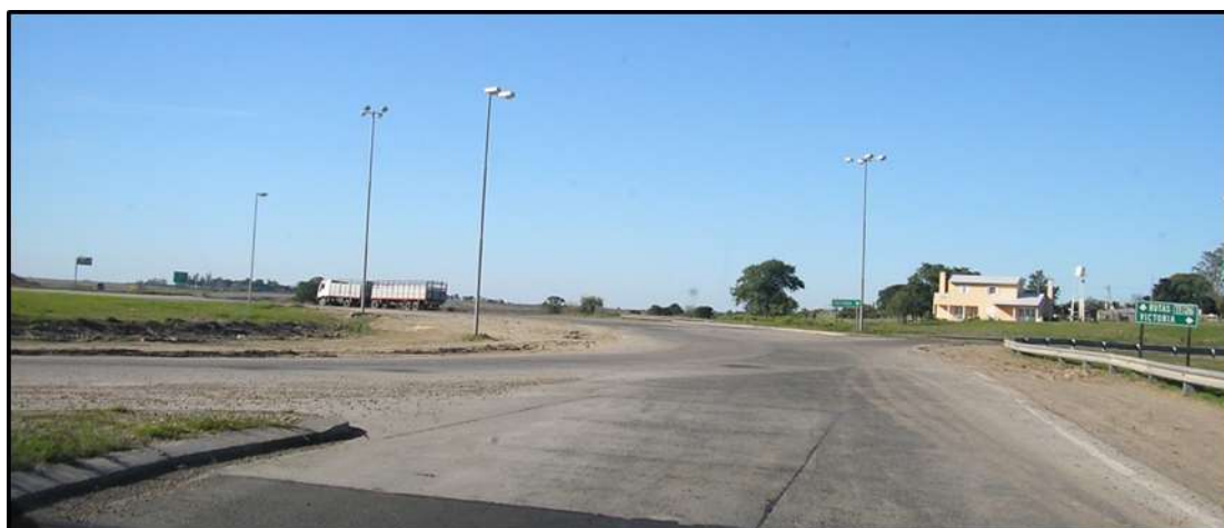
Fotografía N° 1: Calzada anular de hormigón, bordes de calzada sin definir (Intersección N° 1)
