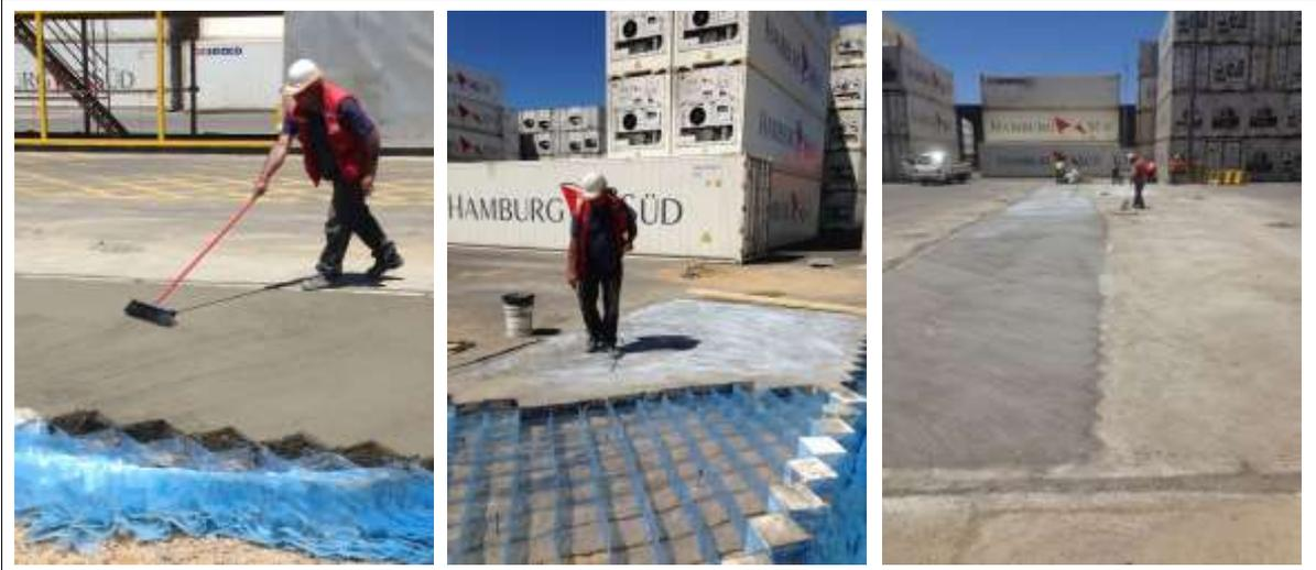
Figura 9: Fotografías proceso de hormigonado de terminación y curado
