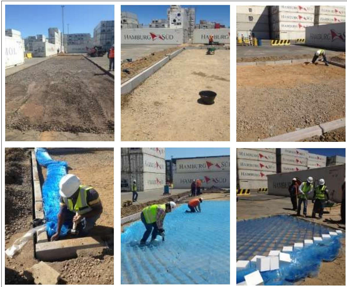
Figura 7: Fotografías proceso de preparación plataforma y colocación geoceldas
