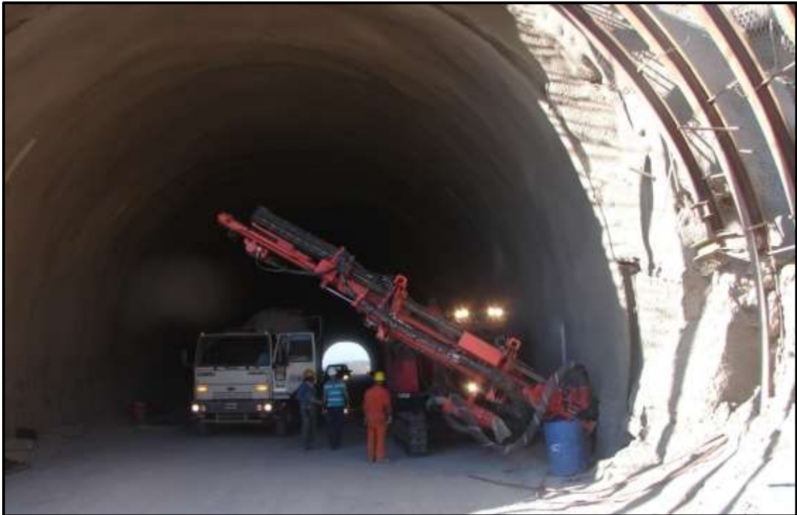
Figura 22: Perforación para la colocación de anclajes para absorber las solicitaciones laterales.
