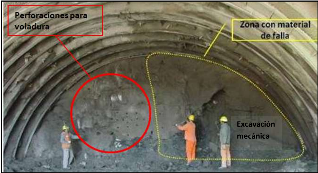
Figura 9: Mostrando los diferentes sectores de la excavación combinada en el túnel.
