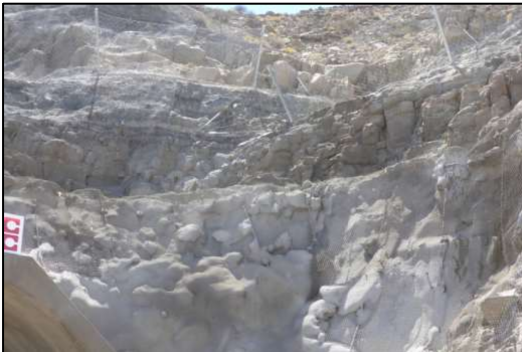
Figura 26: Detalle de la imagen anterior, mostrando la barrera dinámica frontal y lateral del emboquille.
