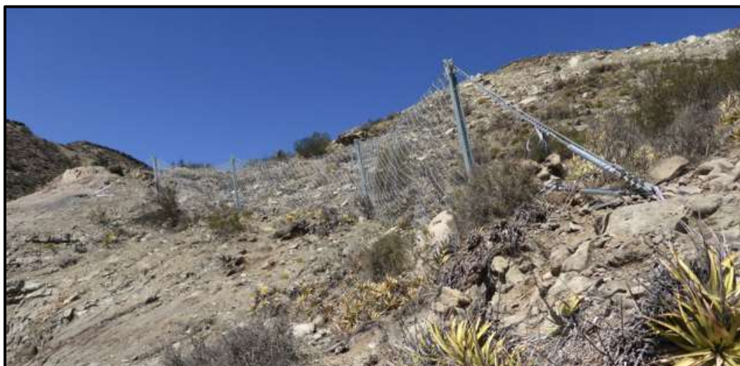
Figura 24: Detalle de la imagen anterior donde se observa la barrera dinámica en la interfaz desmonte - ladera natural.
