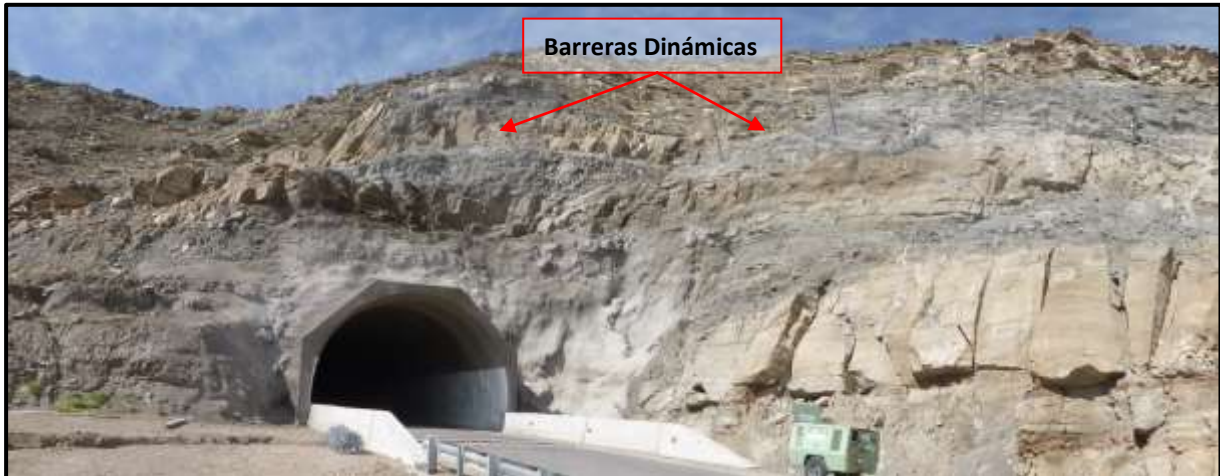
Figura 25: Sistema de protección de laderas para el portal de entrada del túnel 3.
