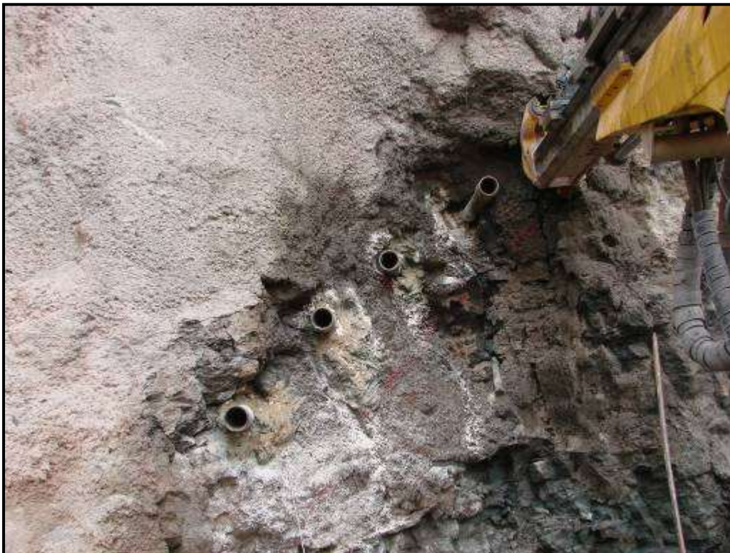
Figura 8: Instalación del paraguas de micropilotes en el portal de entrada del túnel 3.
