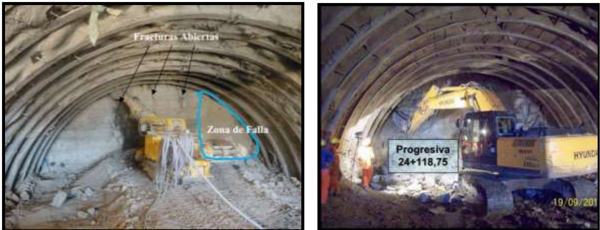
Figura 11: Sistema de excavación mecánica mediante rozadora (izquierda) y martillo neumático (derecha).
