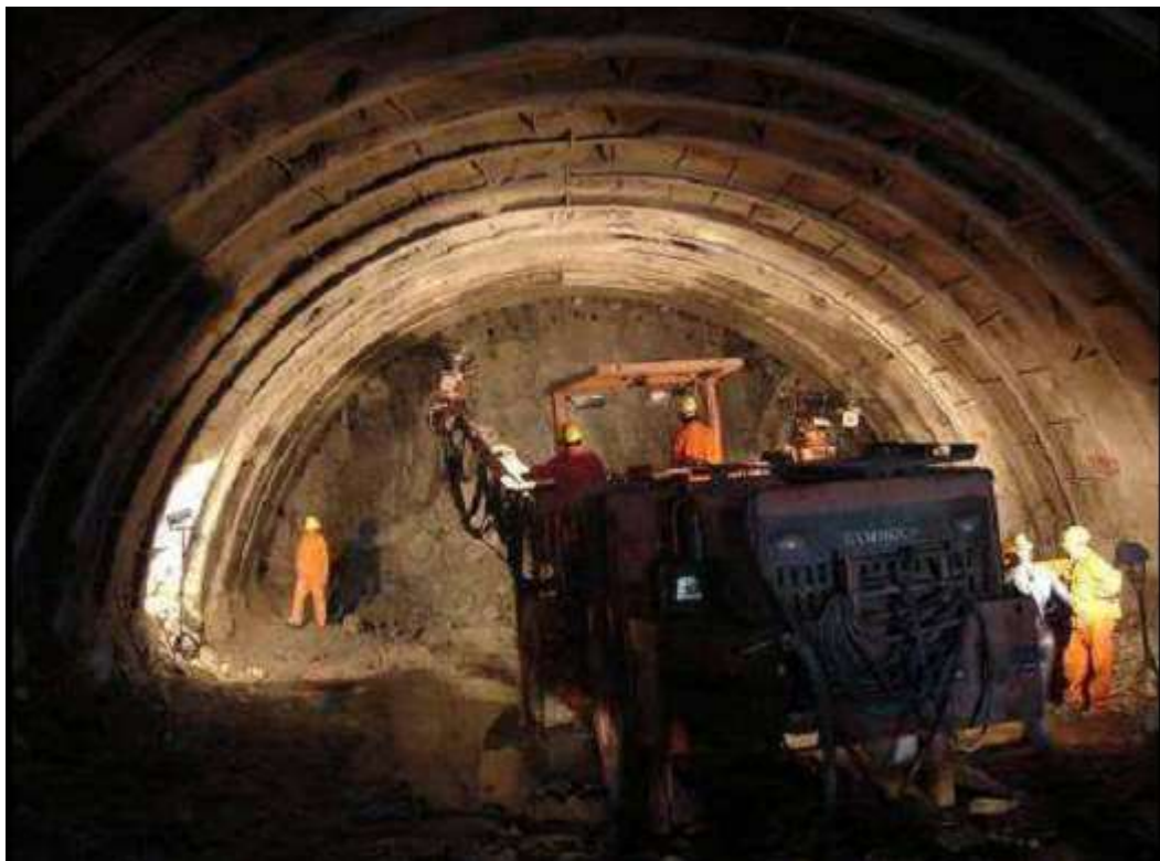
Figura 12: Jumbo realizando las perforaciones en los bloques de arenisca cuarzosa para su posterior excavación por medio de voladura suave.
