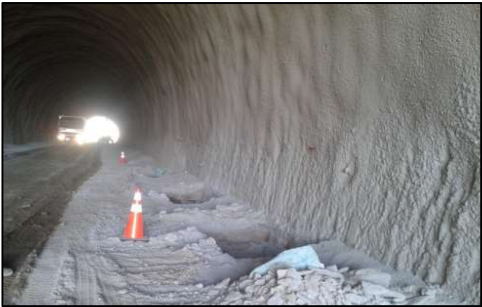
Figura 21: Excavaciones para las fundaciones de las cerchas.
