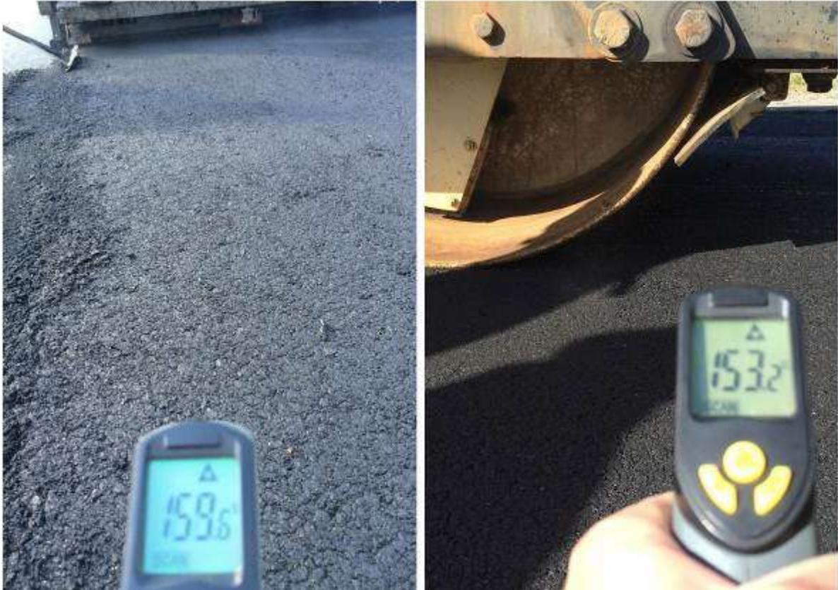
FIGURA 2: TEMPERATURAS DE TENDIDO Y COMPACTACION
