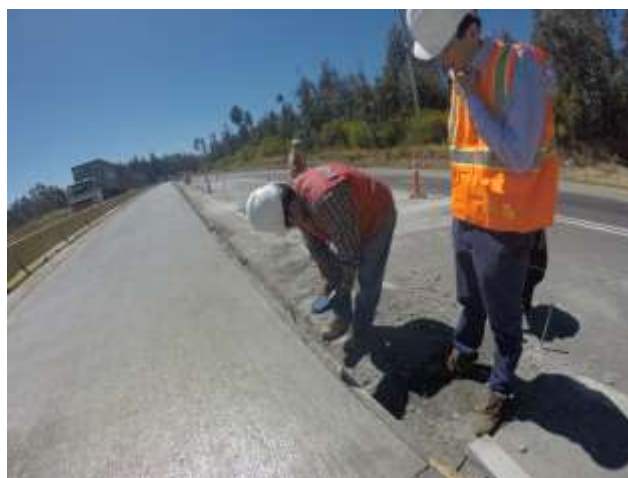
Figura 2: Medición con madurimetro en terreno (Fuente: ICH)
