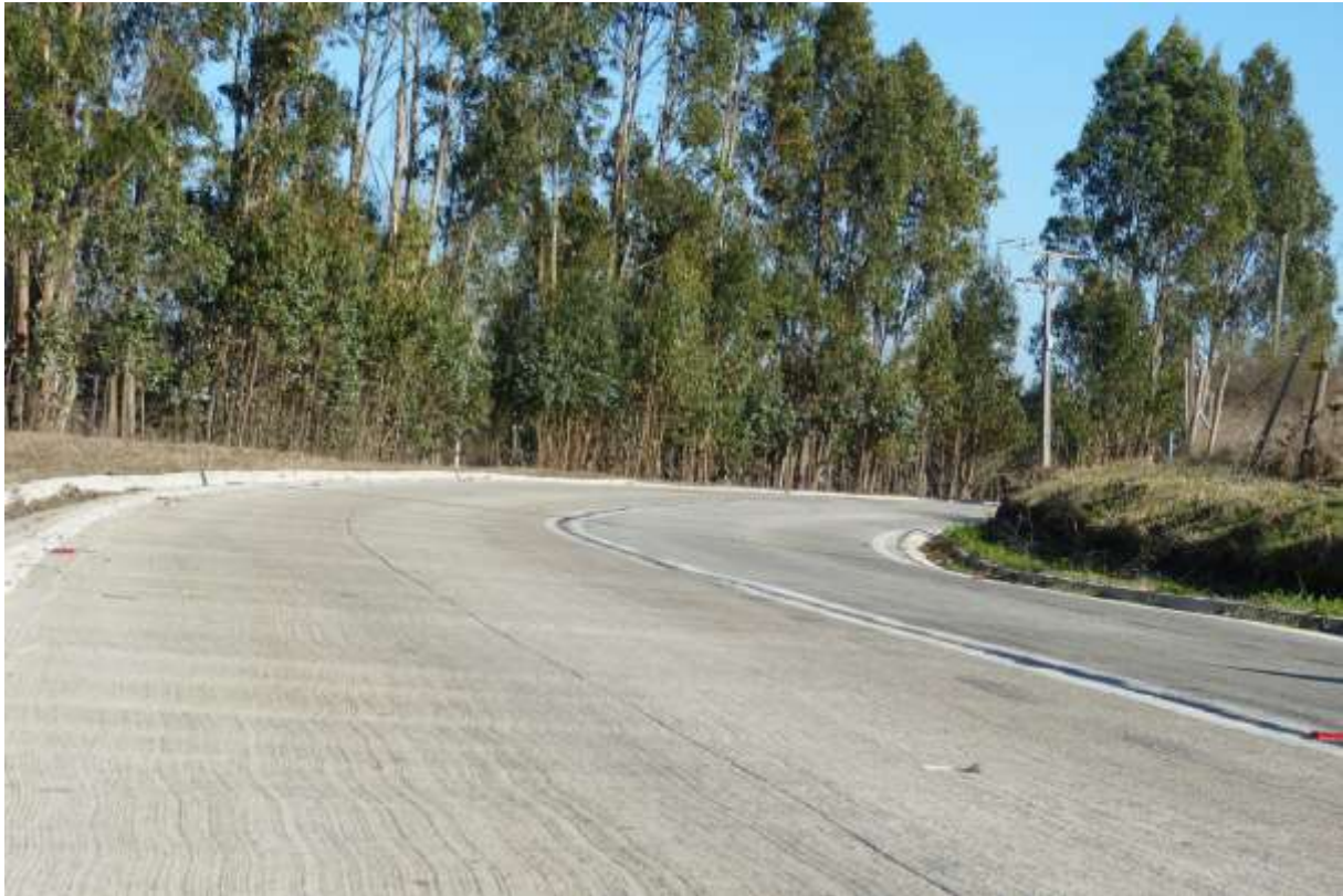
Figura 2: Ruta G84, caso de pavimentos ultradelgados de hormigón con fibra (Fuente: ICH)
