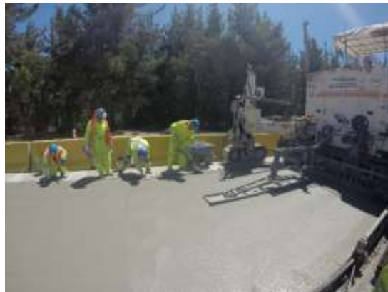
Figura 14. Alisamiento de la superficie.
