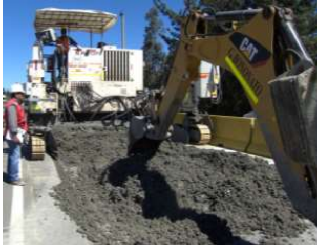
Figura 13. Distribución de hormigón frente a tren pavimentador.
