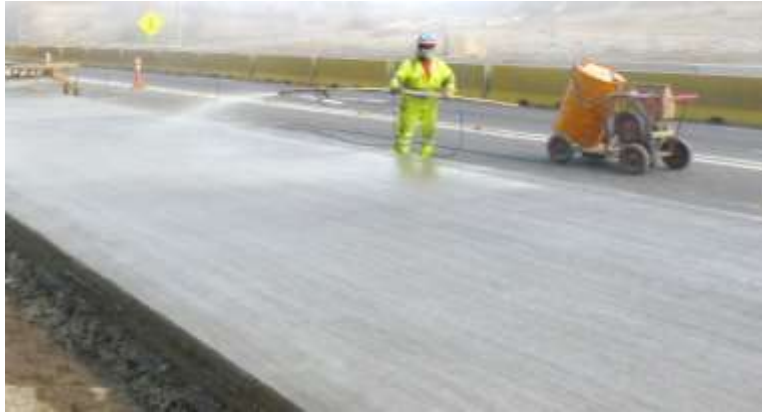
Figura 16. Colocación membrana de curado.
