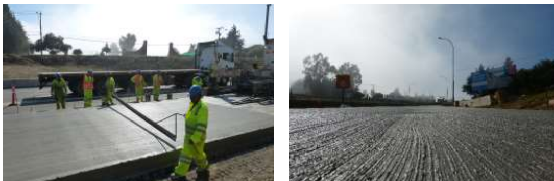
Figura 15. Texturado de Pavimento
