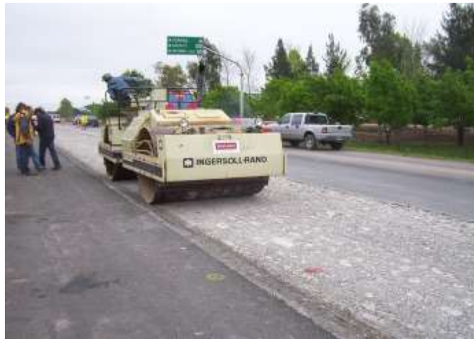
FOTO 3. RODILLADO DEL MATERIAL RESULTANTE
