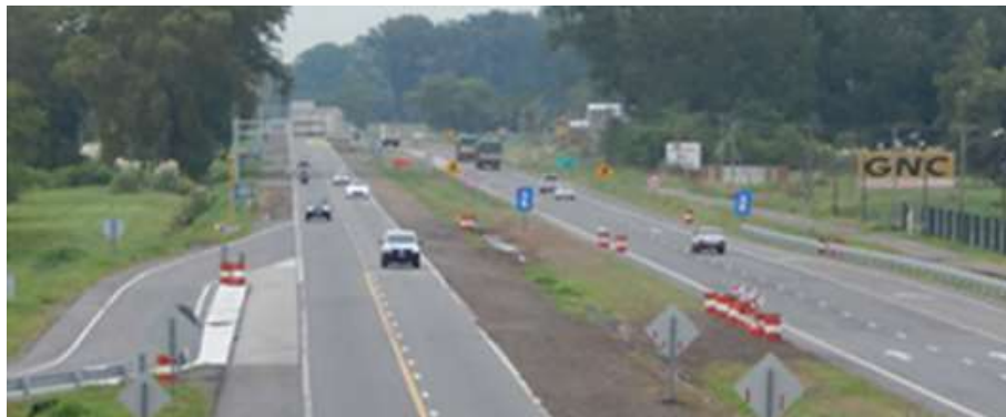
RN7 Autovía Luján-SA. Giles sin control acceso – Exposición de tambores y señales
