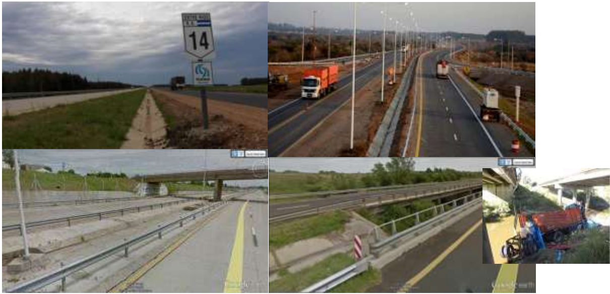
RN14 Mediana ancha con fosas justicieras, cunetas centrales pavimentadas como acceso a hueco entre puentes
