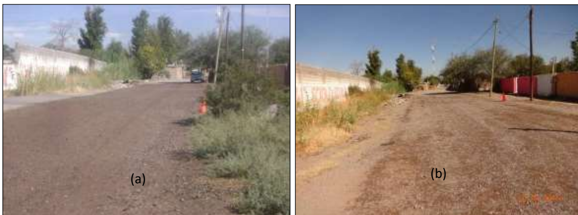
Figura 3. Vista del camino, (a) recién regado con agua, y (b) media hora después del riego
