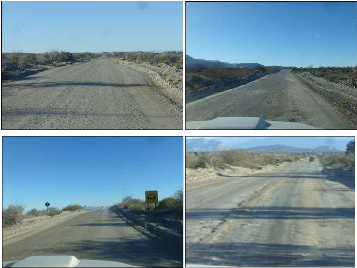
Figura 20. Imágenes del tramo tratado con cloruro de magnesio
