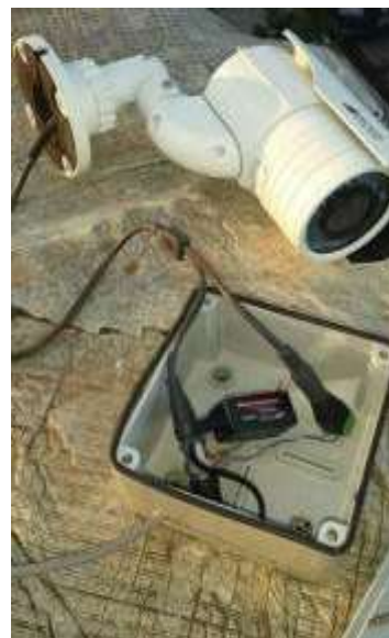
Imagen 3.3-2. Instalación de la cámara. Personal de la DVP. Fuente: Autor
