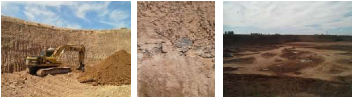
Figura 3. Detalle cantera Zona Concepción
