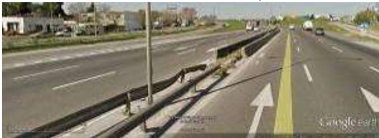
Km 75 Completa desconexión geométrica y estructural de barreras dobles metálicas y de hormigón – Arpones/Frentes romos
