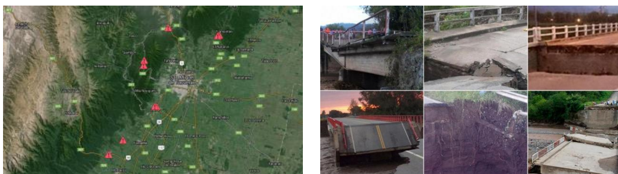
Figura 6. Puentes caídos en Tucumán en 2015 debido a eventos extremos
