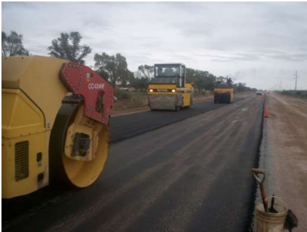
Imagen 34: Equipo de compactación sobre primera capa de base negra.
