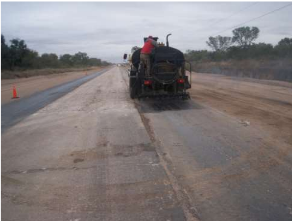
Imagen 32: Riego de liga sobre material granular imprimado
