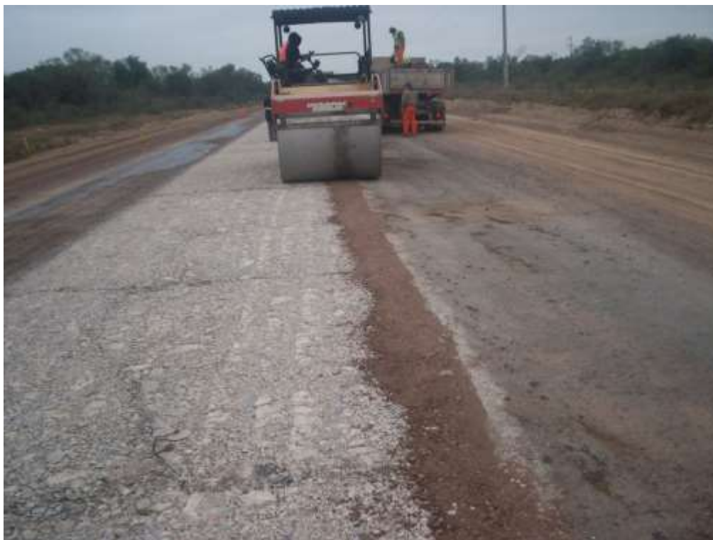
Imagen 27 y 28: Rodillado de material pétreo en borde no confinado
