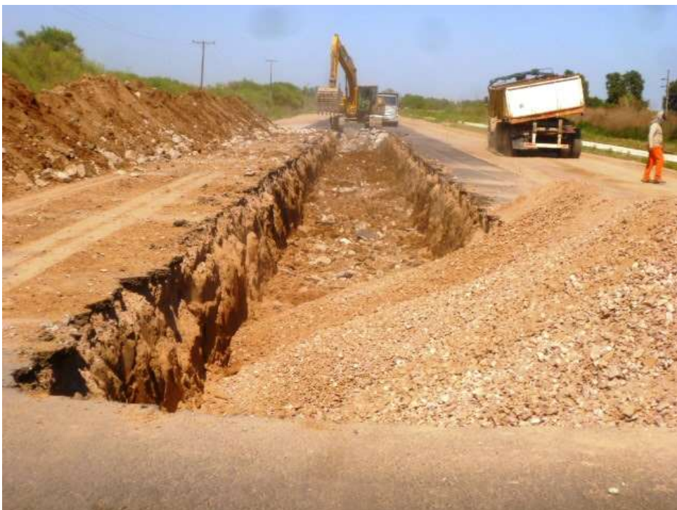
Imagen 37 – 38: Ruptura del pavimento existente
