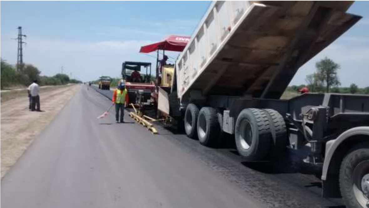
Imagen 47-48: Tren de avance de pavimentación desde la progresiva 18.000 a la 32.000 (carpeta asfáltica)
