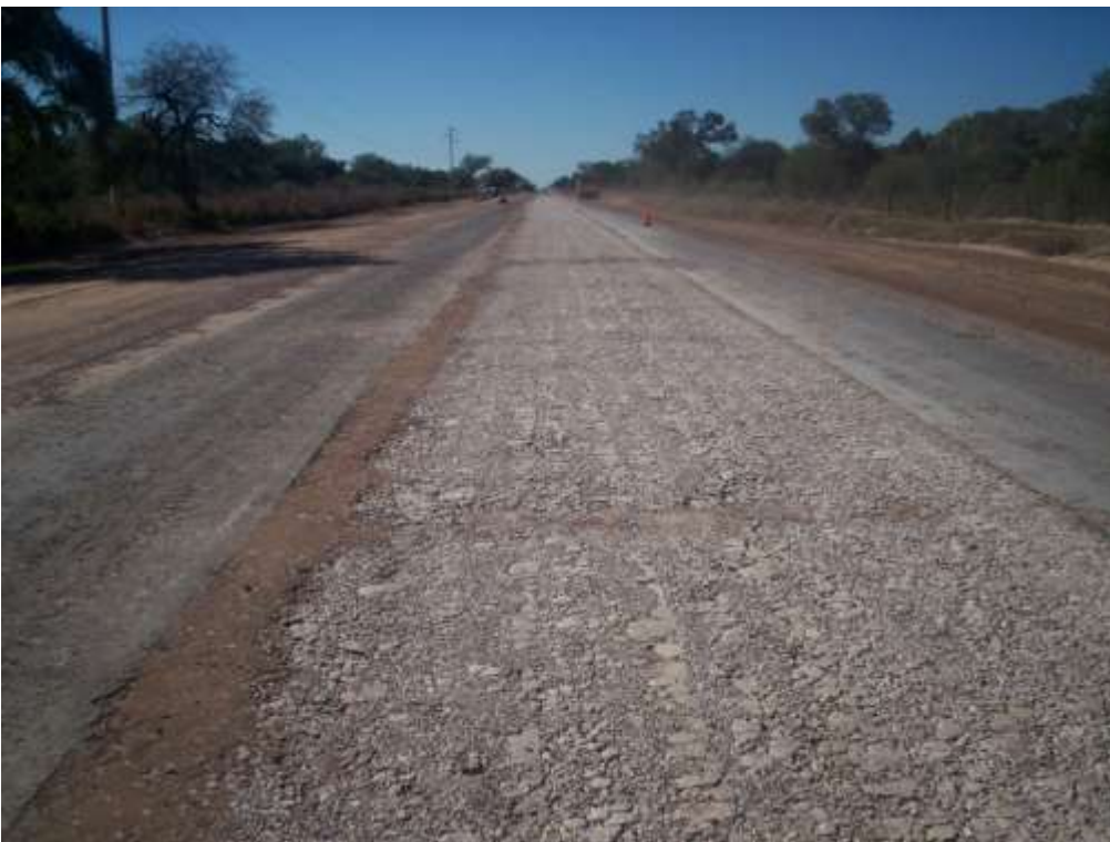
Imagen 30: Vista luego de haber pasado un rodillo autopropulsado a los fines de acomodar las piezas de hormigón triturado
