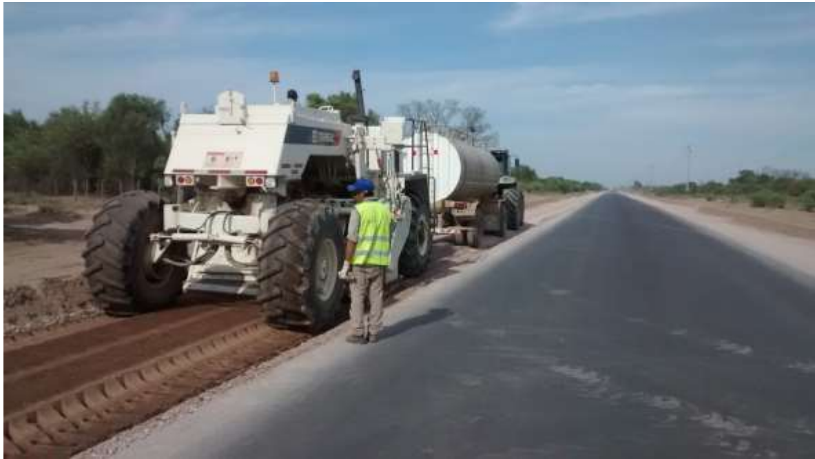
Imagen 51-52: Recicladora Terex
