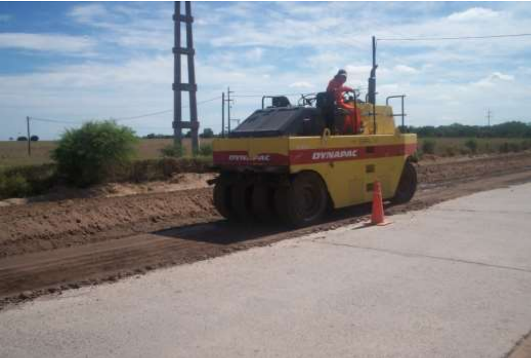
Imagen 12: Compactación de la sub-rasante del ensanche granular, con (6) pasadas de rodillo neumático autopropulsados, previo humedecimiento.
