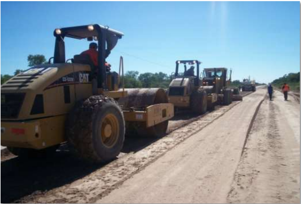
Imagen 16: Compactación del ensanche granular, con rodillos lisos vibrantes autopropulsados.
