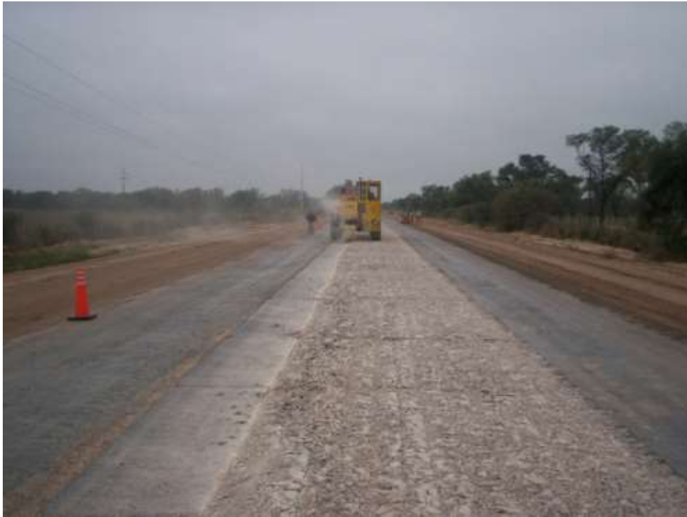
Imagen 20 y 21: Secuencia de trabajo, trituración por franjas acordes al ancho de la plancha de demolición de la máquina, aproximadamente de 20 cm.
