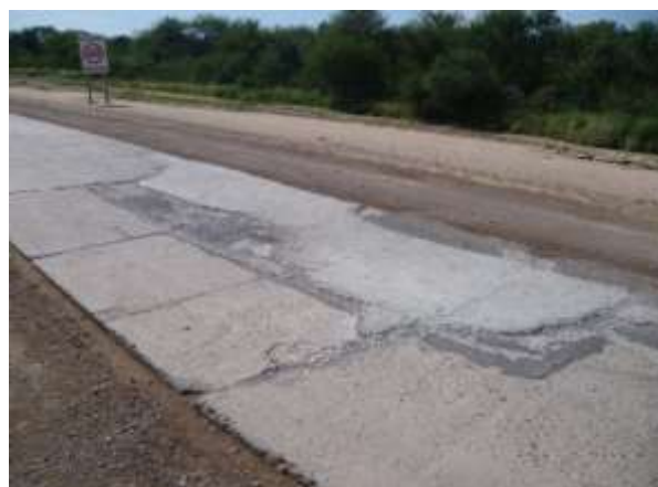
Imagen 3: Reparación de losa con concreto asfáltico
