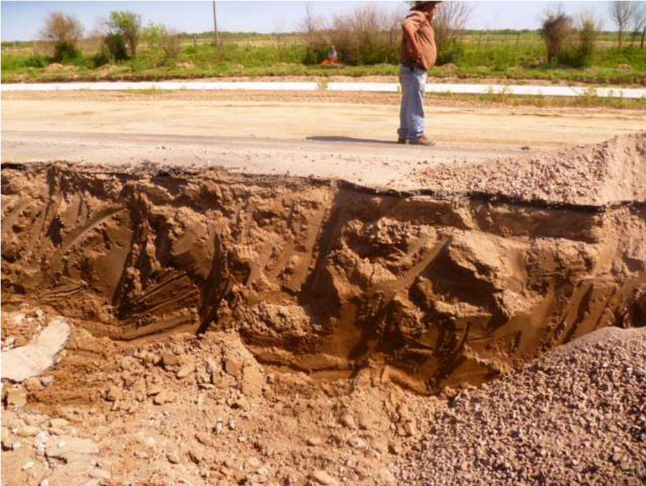
Imagen 39 – 40: Relleno con material de Base Granular
