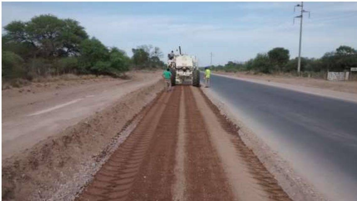
Imagen 50: Uso de la recicladora para la confección de las banquetas
