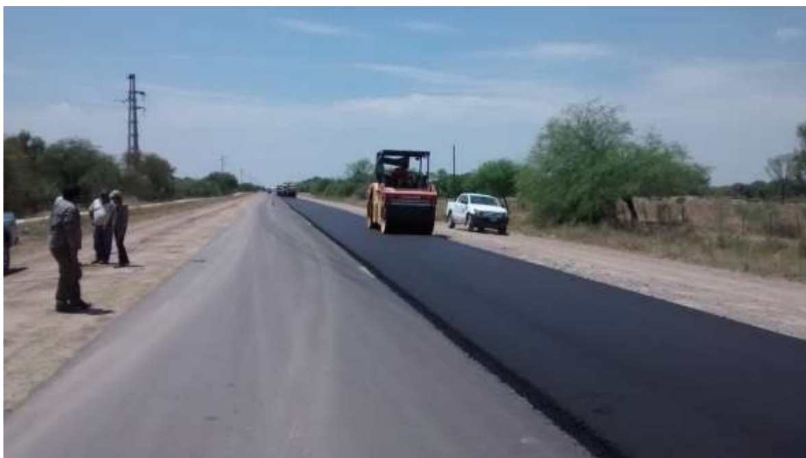
Imagen 49: Tareas de compactación
