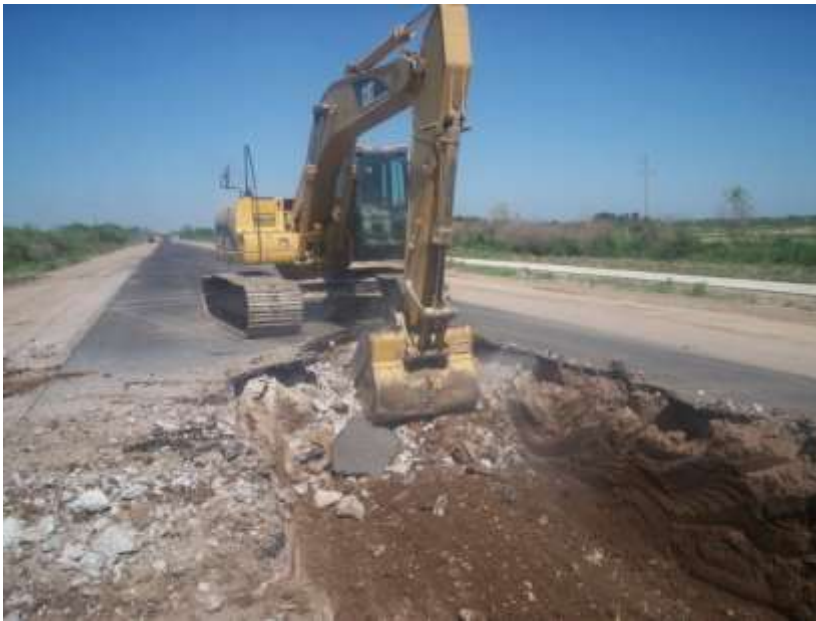
Imagen 37 – 38: Ruptura del pavimento existente
