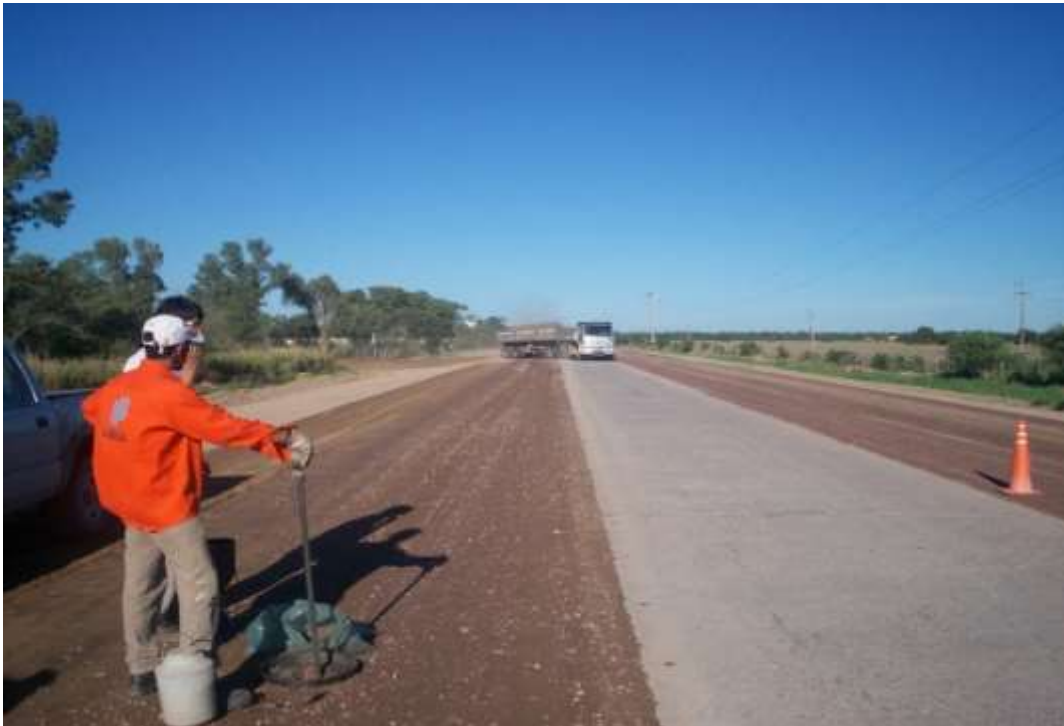
Imagen 17: Ensayo de densidad en el ensanche granular terminado, entre Prog. 23000 a 19000
