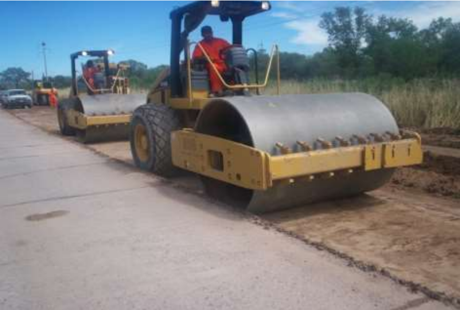
Imagen 12: Compactación de la sub-rasante del ensanche granular, con (6) pasadas de rodillo neumático autopropulsados, previo humedecimiento.
