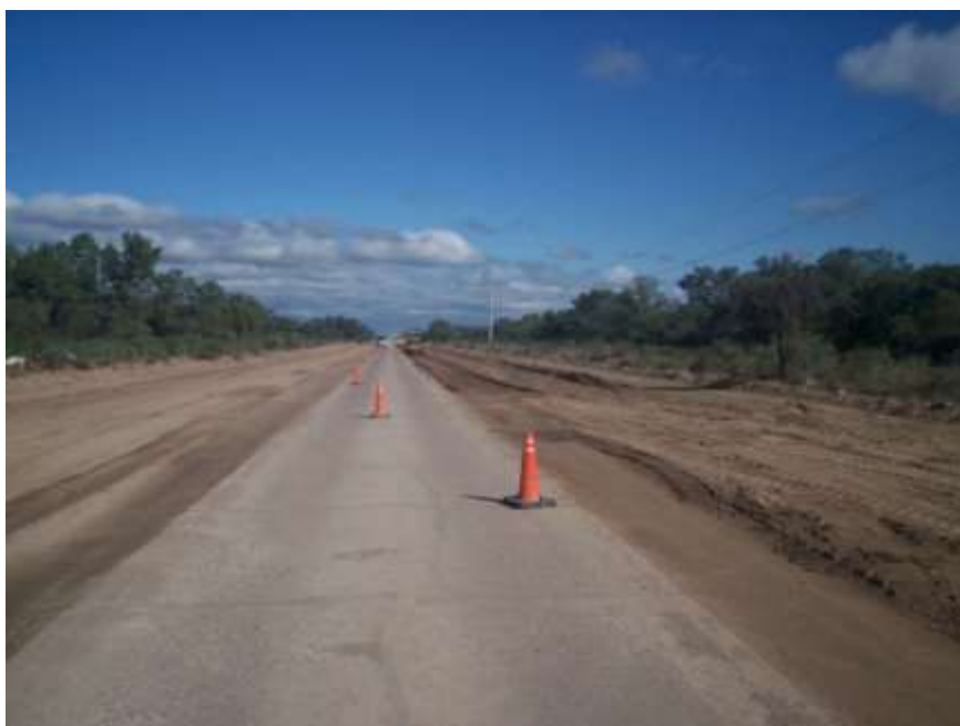
Imagen 9: Conos delineadores en zona de obra
