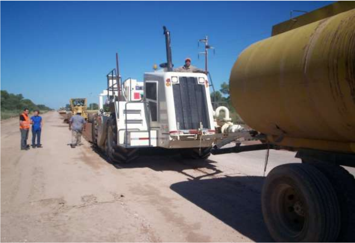
Imagen 16: Compactación del ensanche granular, con rodillos lisos vibrantes autopropulsados.
