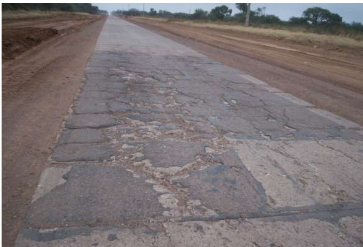
Imagen 5: Reparación de losa fracturada con concreto asfáltico
