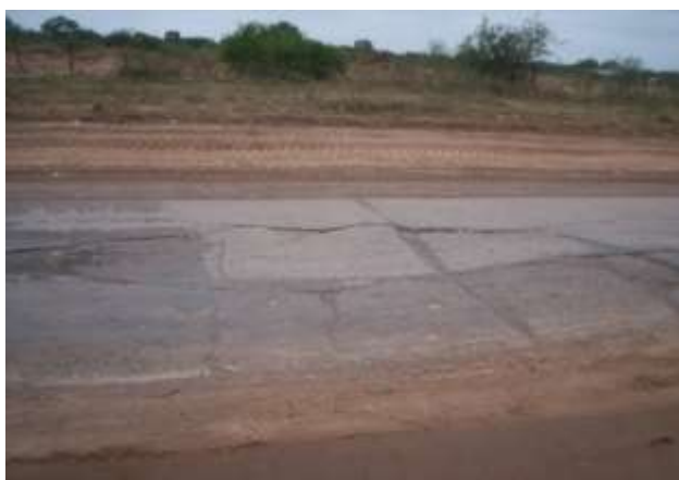
Imagen 3: Reparación de losa con concreto asfáltico
