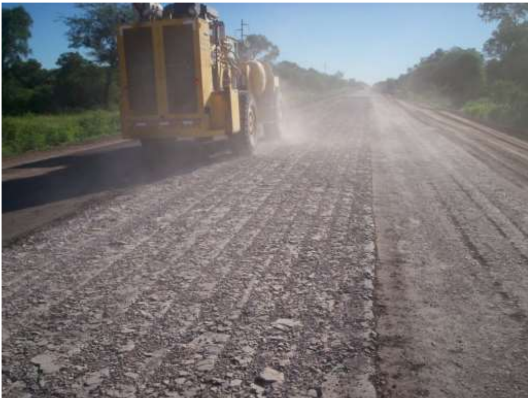
Imagen 20 y 21: Secuencia de trabajo, trituración por franjas acordes al ancho de la plancha de demolición de la máquina, aproximadamente de 20 cm.
