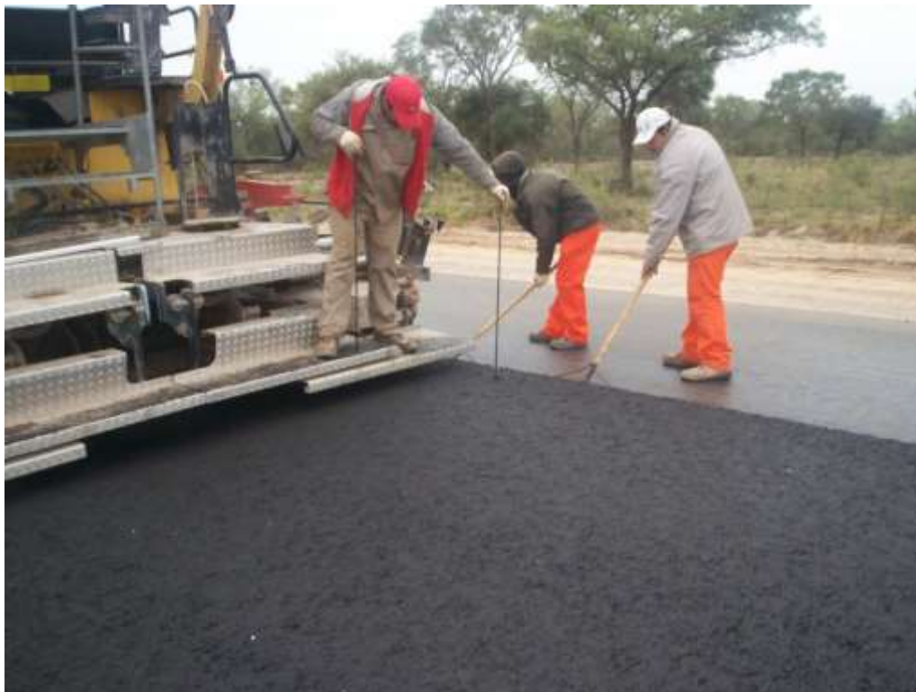
Imagen 33: Control de espesor en la pavimentadora.
