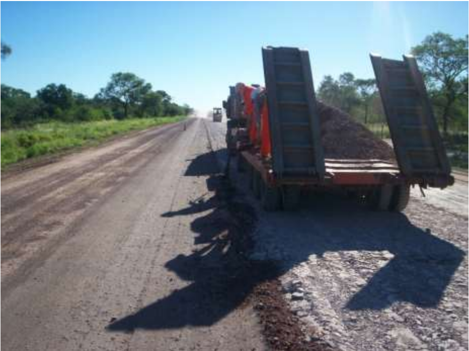
Imagen 24 y 25: material de Base granular agregado y rodillado.
