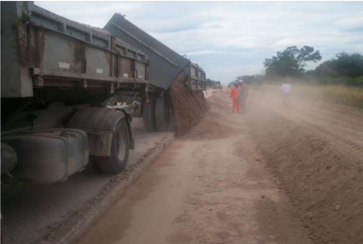
Imagen 14: Aporte de material pétreo para base, desde acopio en campamento.
