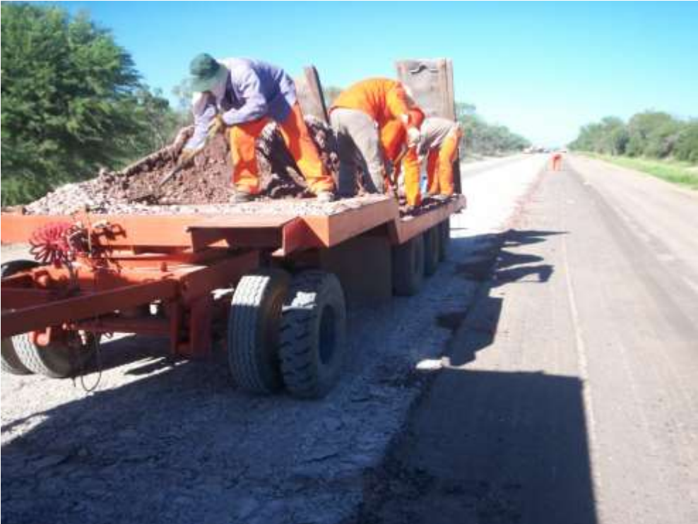
Imagen 24 y 25: material de Base granular agregado y rodillado.
