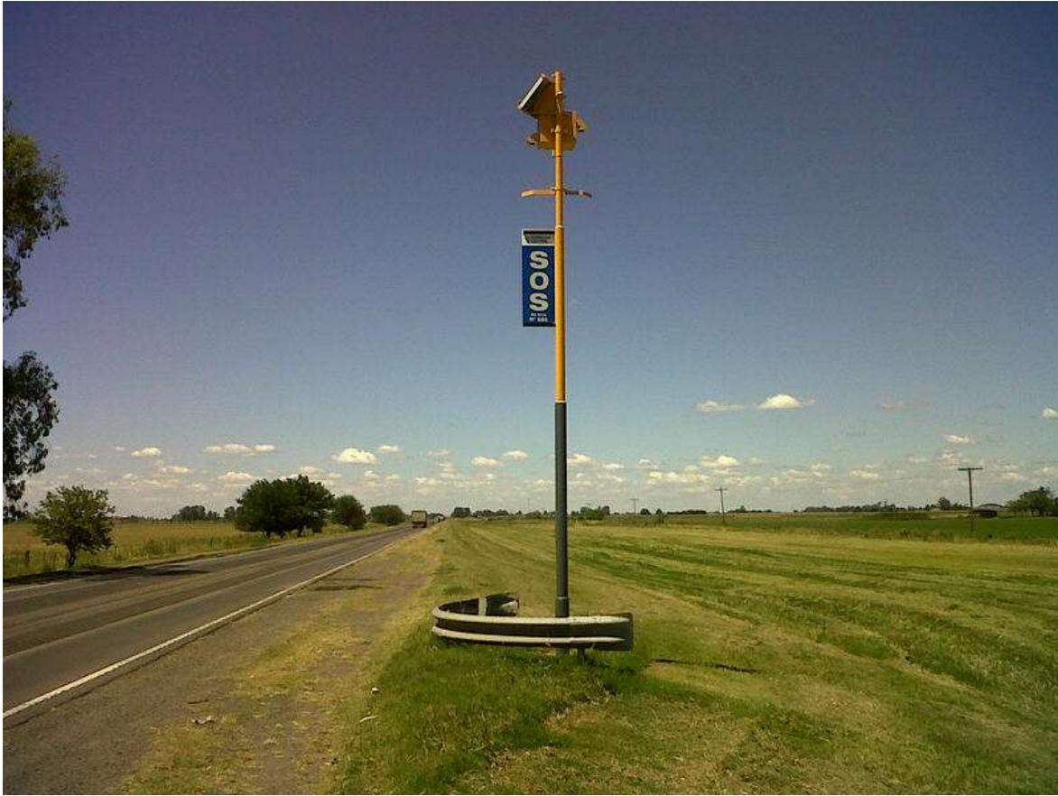
*FISICA:* Cada uno de estos Puntos SOS, posee una construcción robusta, con un poste de al menos 4 metros, con una protección por baranda metálica (tipo Flex Beam), con un panel accesible al usuario mediante un solo botón antivandálico.
