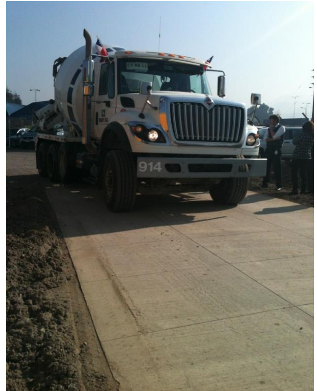
Tramo de prueba de pavimento de Hormigón ultradelgado con fibras
