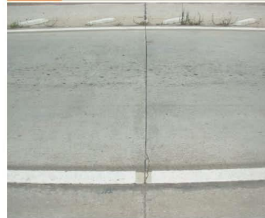
Figura 7-20: Despostillamiento de alta severidad.
