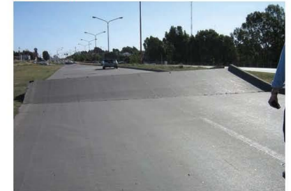
Figura 7-21: Levantamiento de losas (Blow up).
