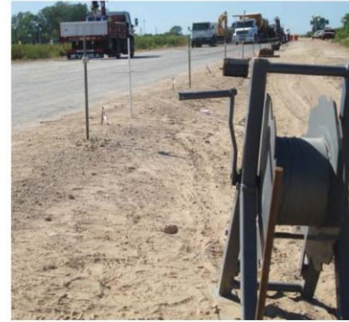
Figura 5-23: Malacate para el tensado de los hilos guía.
