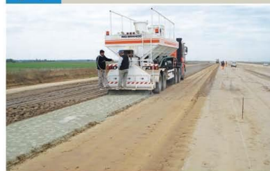
Figura 5-6: Distribuidor de cemento.
