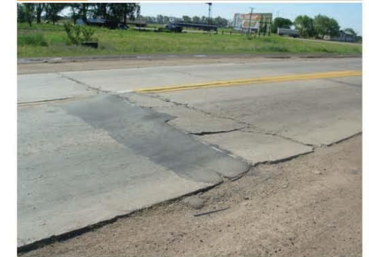
Figura 7-21: Levantamiento de losas (Blow up).
