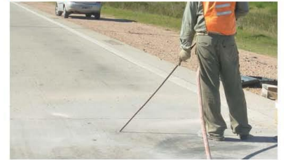
Figura 7-67: Perforaciones listas para la instalación de barras.
