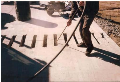
Figura 7-60: Limpieza de las ranuras.
