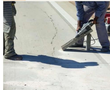
Figura 7-65: Perforación a 35° para la colocación de las barras.
