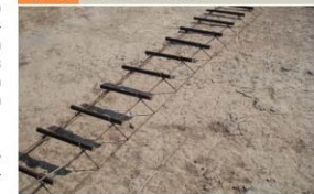
Figura 3-6: Colocación con Canastos.
