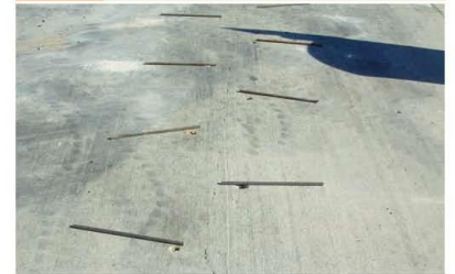
Figura 7-67: Perforaciones listas para la instalación de barras.
