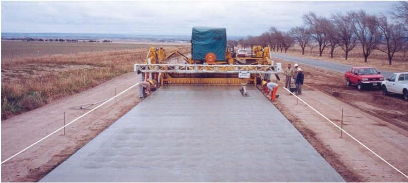
Figura 5-21: Pavimentación con doble línea guía.
