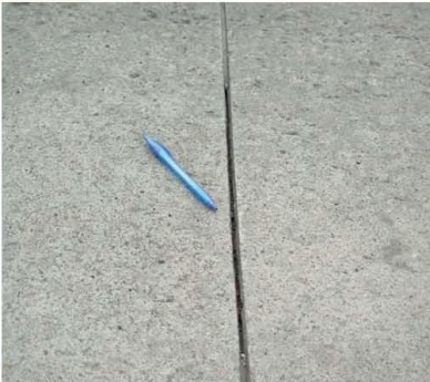
Figura 7-18: Material de sellado ausente.
