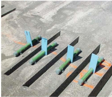
Figura 7-61: Ranuras y pasadores preparados para su instalación. [IGGA]
