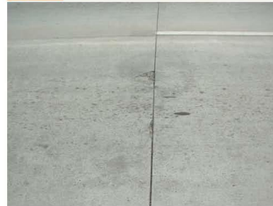
Figura 7-20: Despostillamiento de alta severidad.
