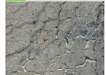
Figura 4-27: Reacción álcali-silíce.
