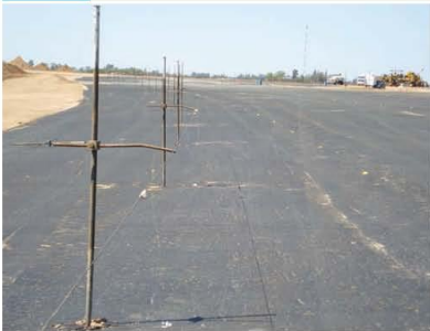
Figura 5-22: Soportes guías (pines).
