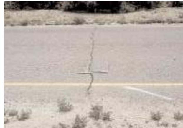
Fisuración térmica.
