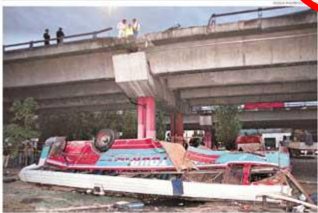
La muerte en chárter ➤ Así quedó el colectivo que ayer a las 5.15 chocó contra el guardarrail de la autopista 9 de Julio Sur y cayó desde 8 metros. Hubo tres muertos y diez heridos. El chárter iba de Constitución a Florencio Varela. Al parecer, se rompió la dirección. Había superado una verificación técnica el mes pasado. PÁG. 26
